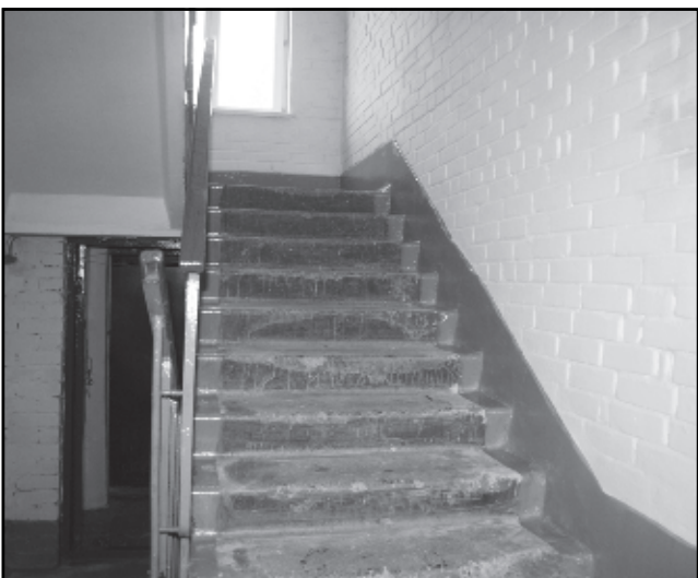
Подъезд дома № 20 на улице 60 лет Октября теперь радуется жильцов свежими красками.
