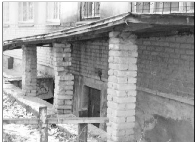
Подвал в доме № 171 на ул. 8 Марта: так было...
