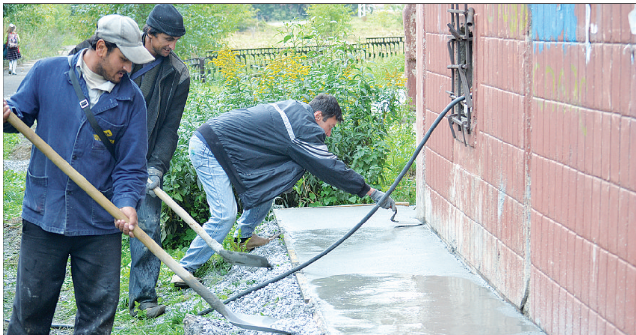
Дом № 33 на ул. Ак. Павлова благодаря активному взаимодействию с управляющей компанией «Рассвет-Энерго» теперь будет с новой отмосткой.
