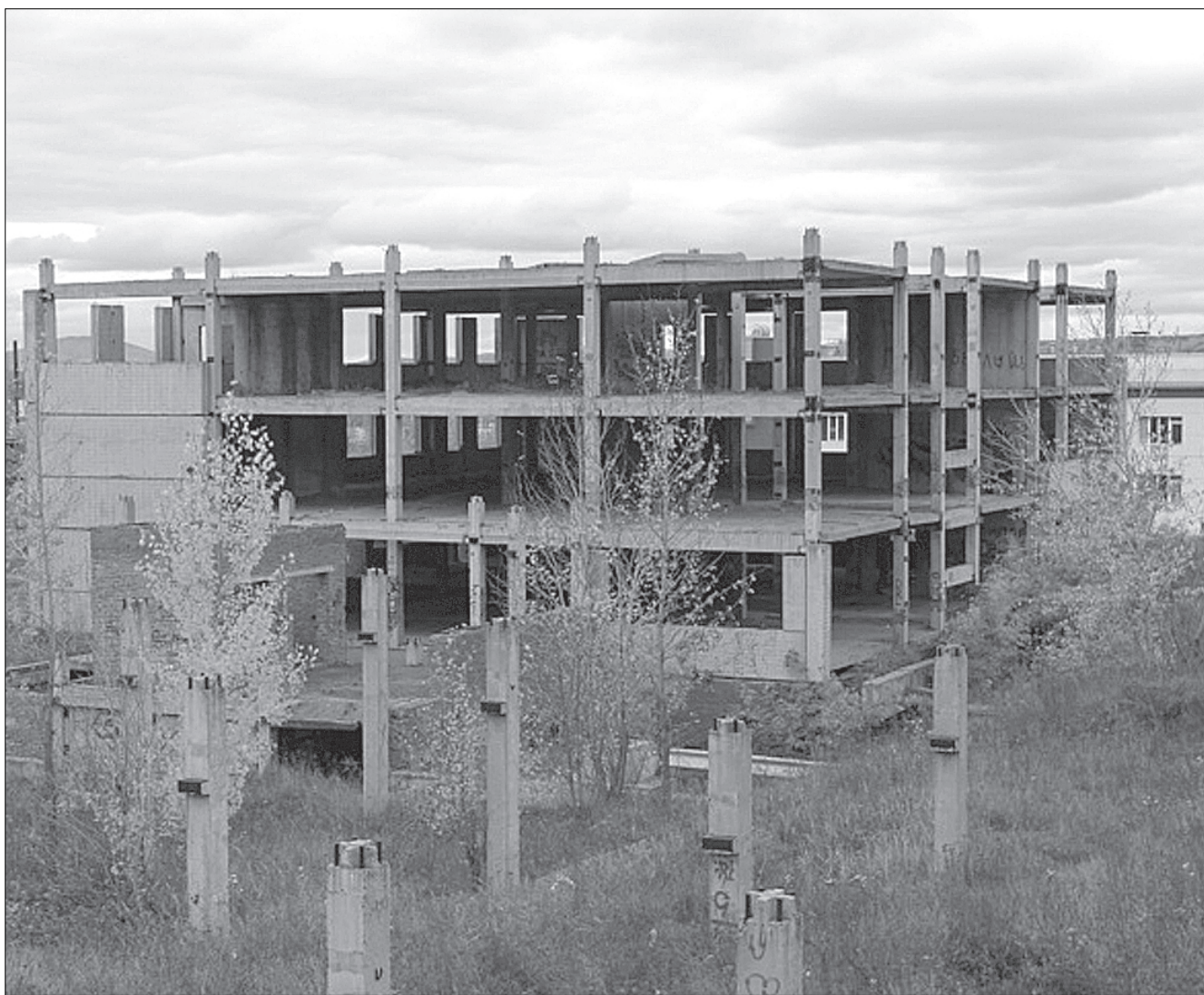
Вместо разваливающегося здания здесь вырастет многоэтажка.
