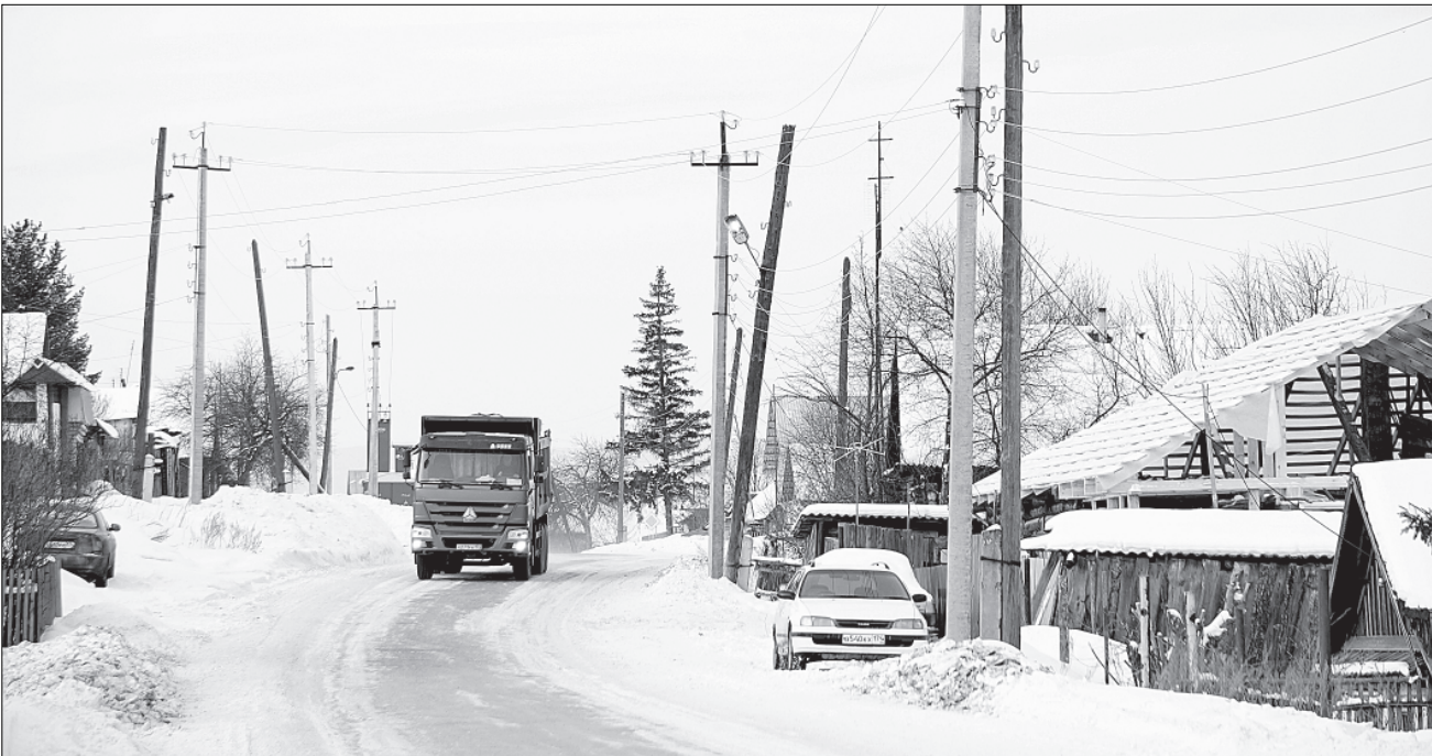
В поселке Верхний Атян проведена модернизация электросетей.
