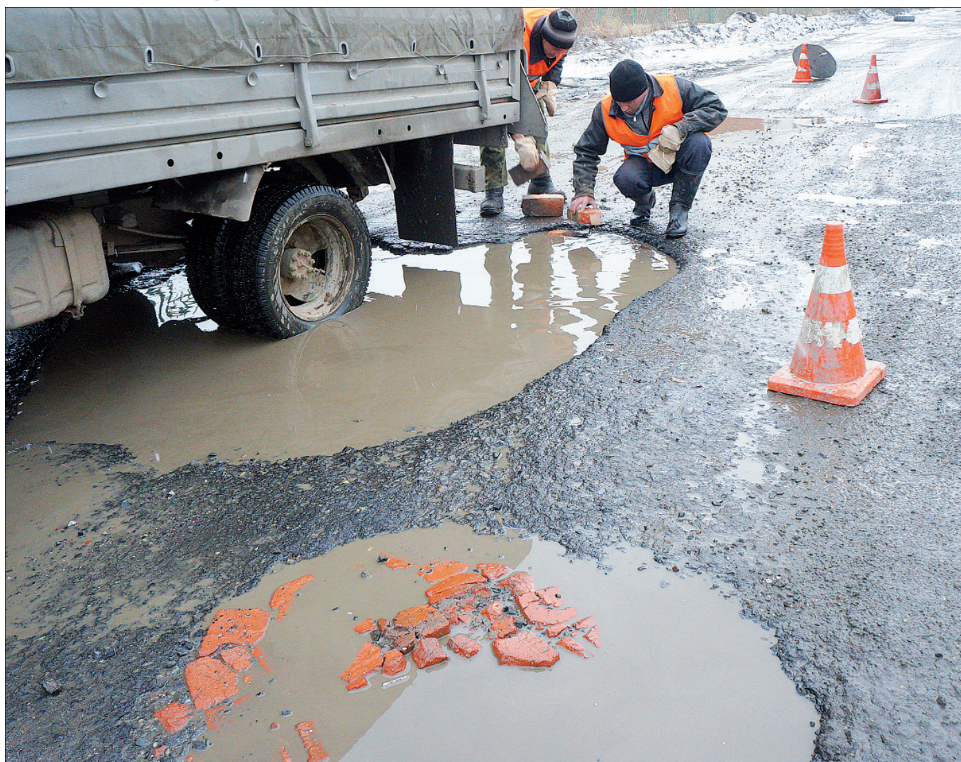
За неимением асфальтобетонных смесей ямы выкладывают кирпичами.
