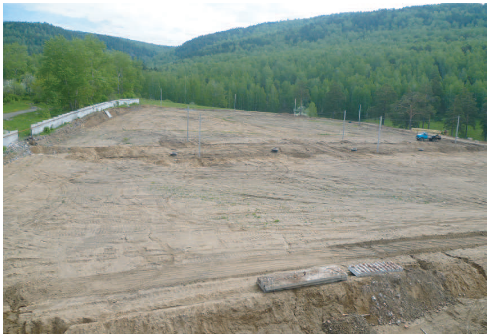
Подготовленная строительная площадка...
