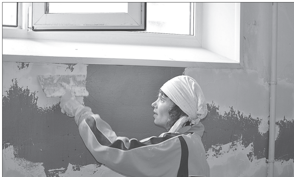
В доме № 33 на ул. Ак. Павлова ремонтируется уже четвертый подъезд.
