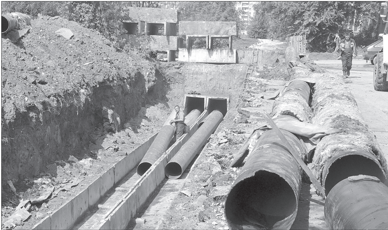
Ремонтные работы на теплосетях завершатся до начала отопительного сезона.
