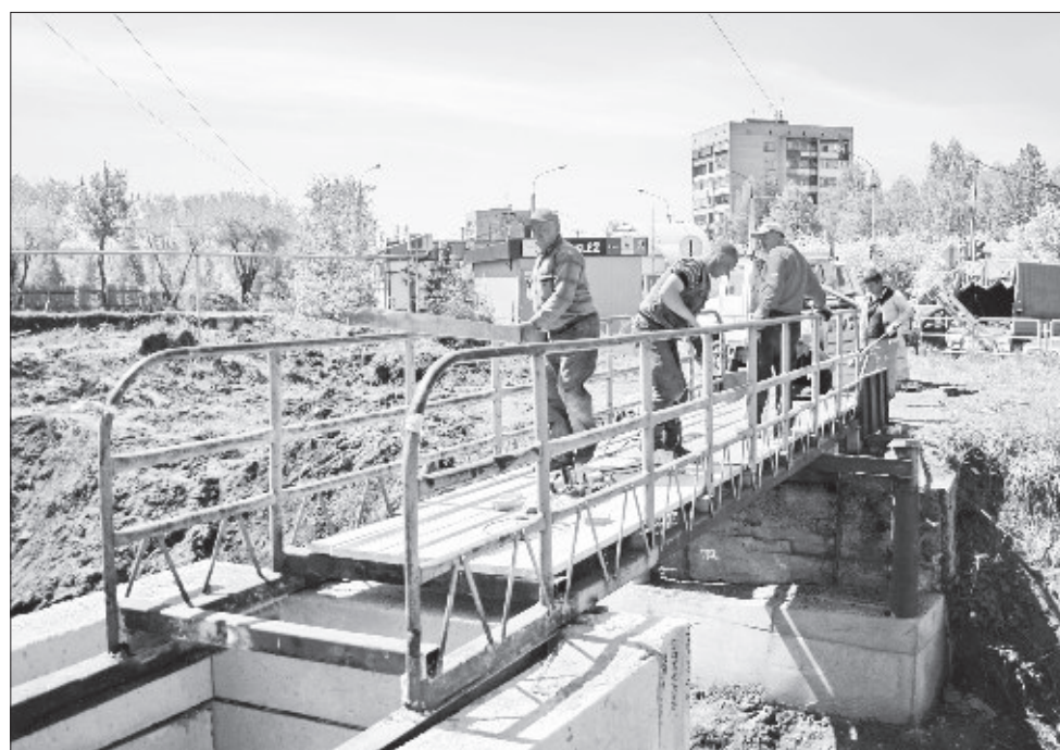
По отремонтированному мосту теперь можно будет ходить без опаски.
