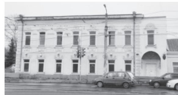
Дом Смолиных-Новиковых, в числе прочих объектов культурного наследия Челябинска, приведут в порядок к саммитам ШОС и БРИКС.
