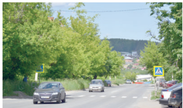
Депутат и жители добились проведения капитального ремонта основных дорог — от поселка Динамо до трассы на Златоуст, Динамовского шоссе и улицы Готвальда.
