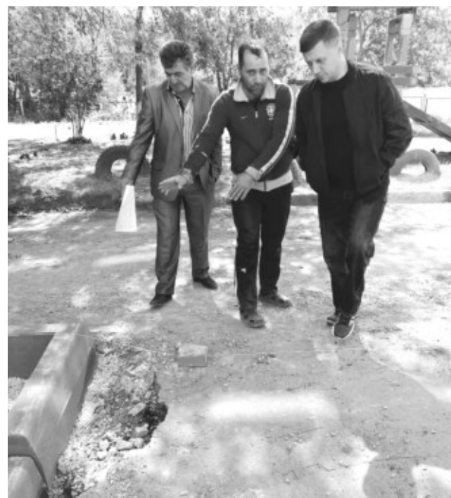
Активные работы по благоустройству начались в округе депутата Андрея Котова.
