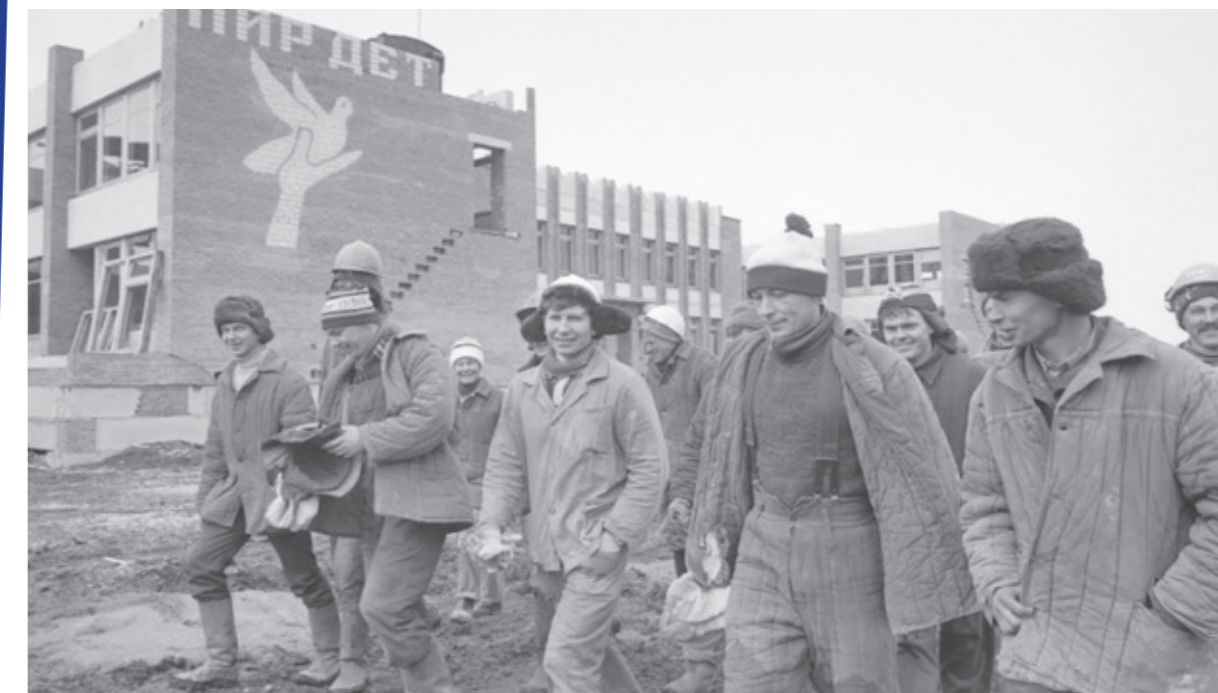
Строительство МЖК на улице Уральских Добровольцев стало ударной комсомольской стройкой. Фото С. Краснопева.
