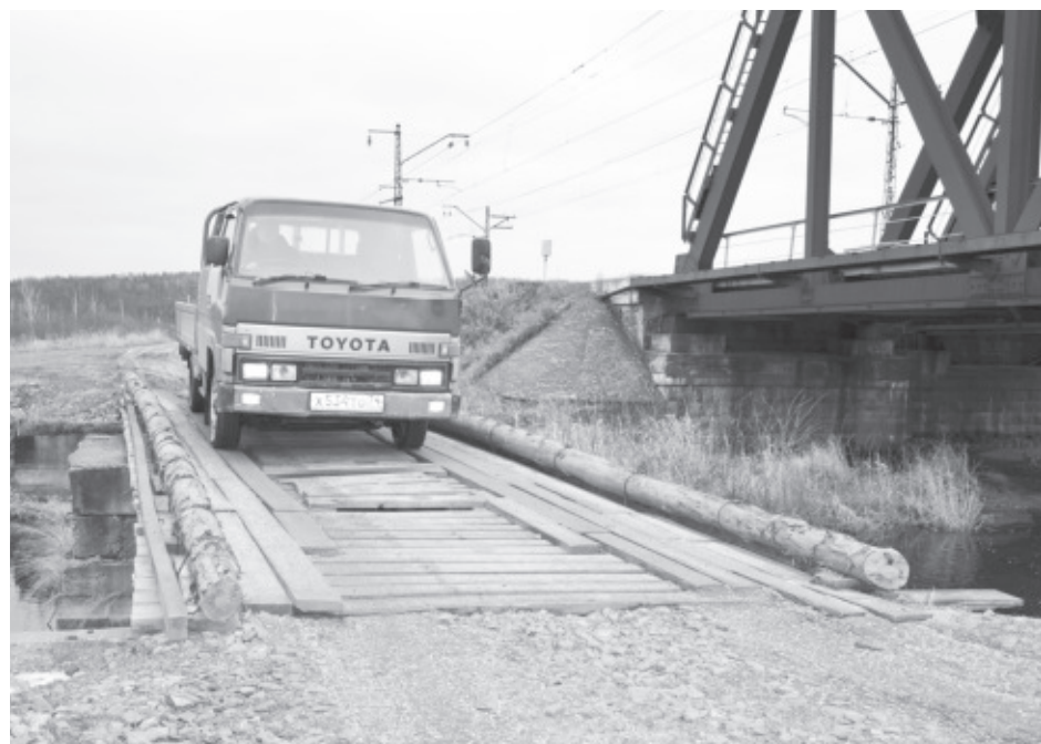
Мост от станции Флюсовая до станции Тургояк — уже третий в 20 округе, который жители восстанавливают своими силами при участии депутата Марата Шакирова.
