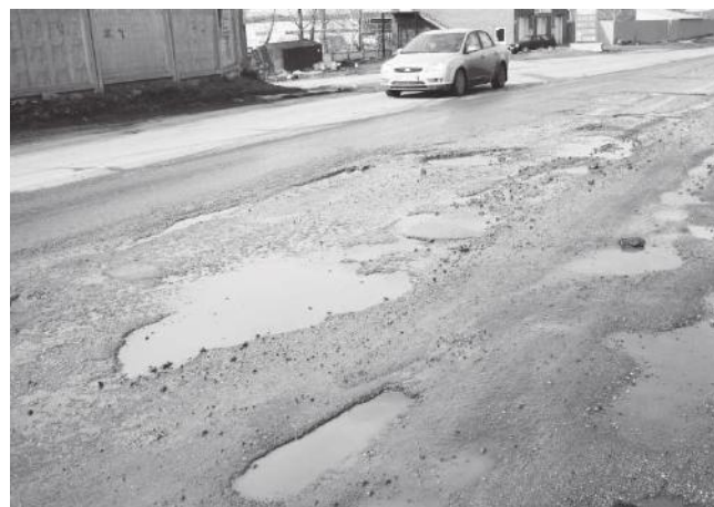
Объездная Тургорякского шоссе выглядит так, будто ямочного ремонта в прошлом году вовсе и не было.
