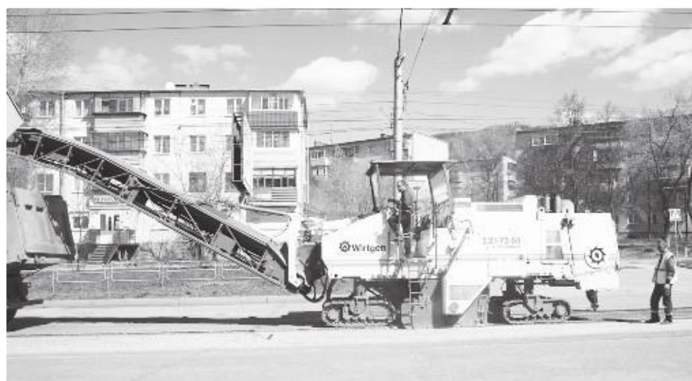
Дороги Миасса уже подготовлены к капитальному ремонту — старый асфальт срезан, осталось дожидаться начала работ.
