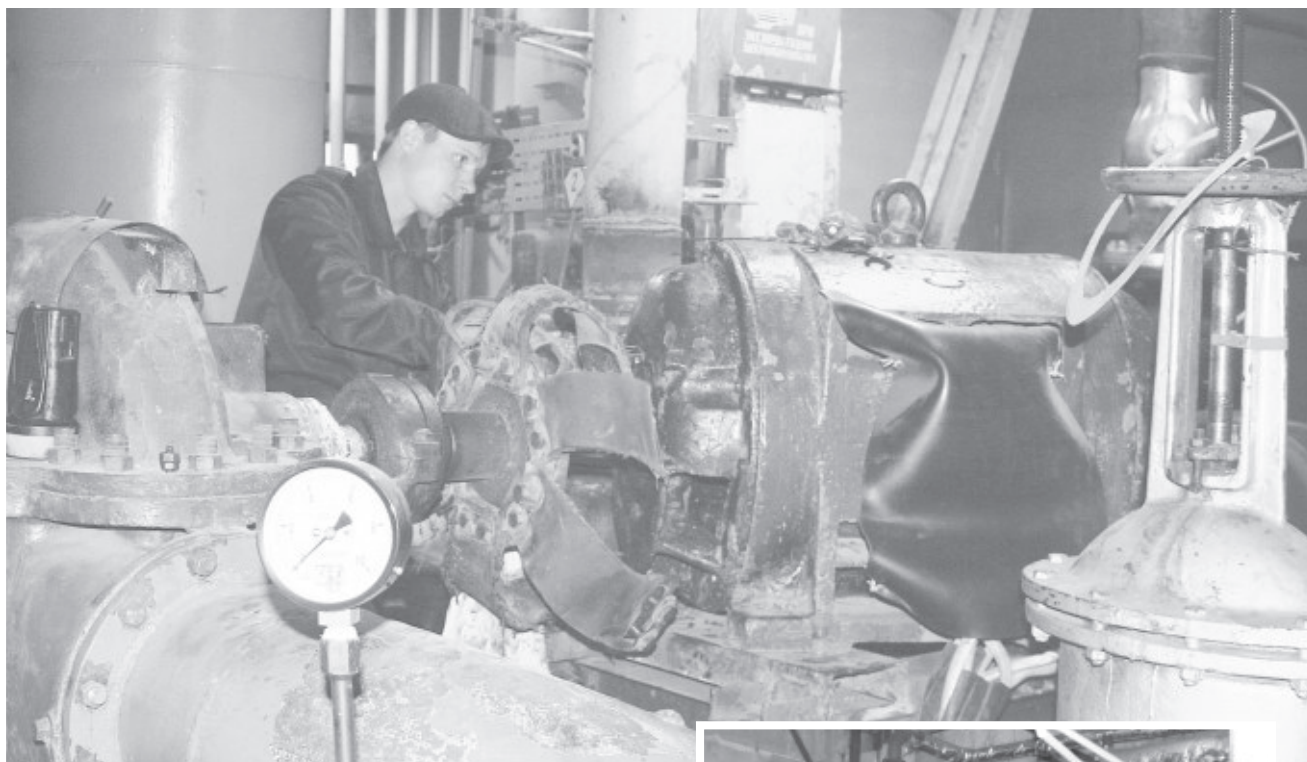
Сейчас ремонтные работы идут в котельной на Пролетарской, 1, отапливающей район бывшего МИЗа.
