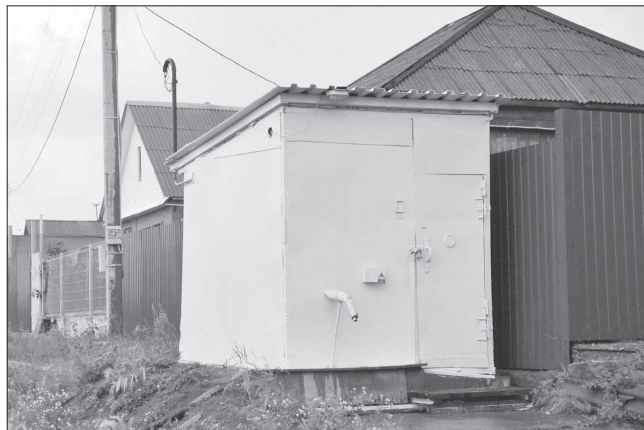
На ул. Фрунзе пробурена скважина и появился хорошо обустроенный артезианский трубчатый колодец.
