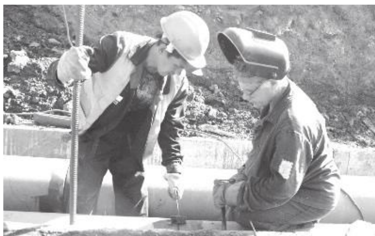
Вода в домах появилась, теперь самое главное — подготовить новую теплотрассу к гидравлическим испытаниям. Их начало намечено на 15 августа.
