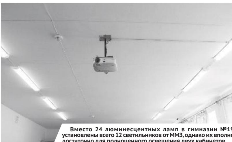
Вместо 24 люминесцентных ламп в гимназии №19 установлены всего 12 светильников от ММЗ, однако их вполне достаточно для полноценного освещения двух кабинетов.
