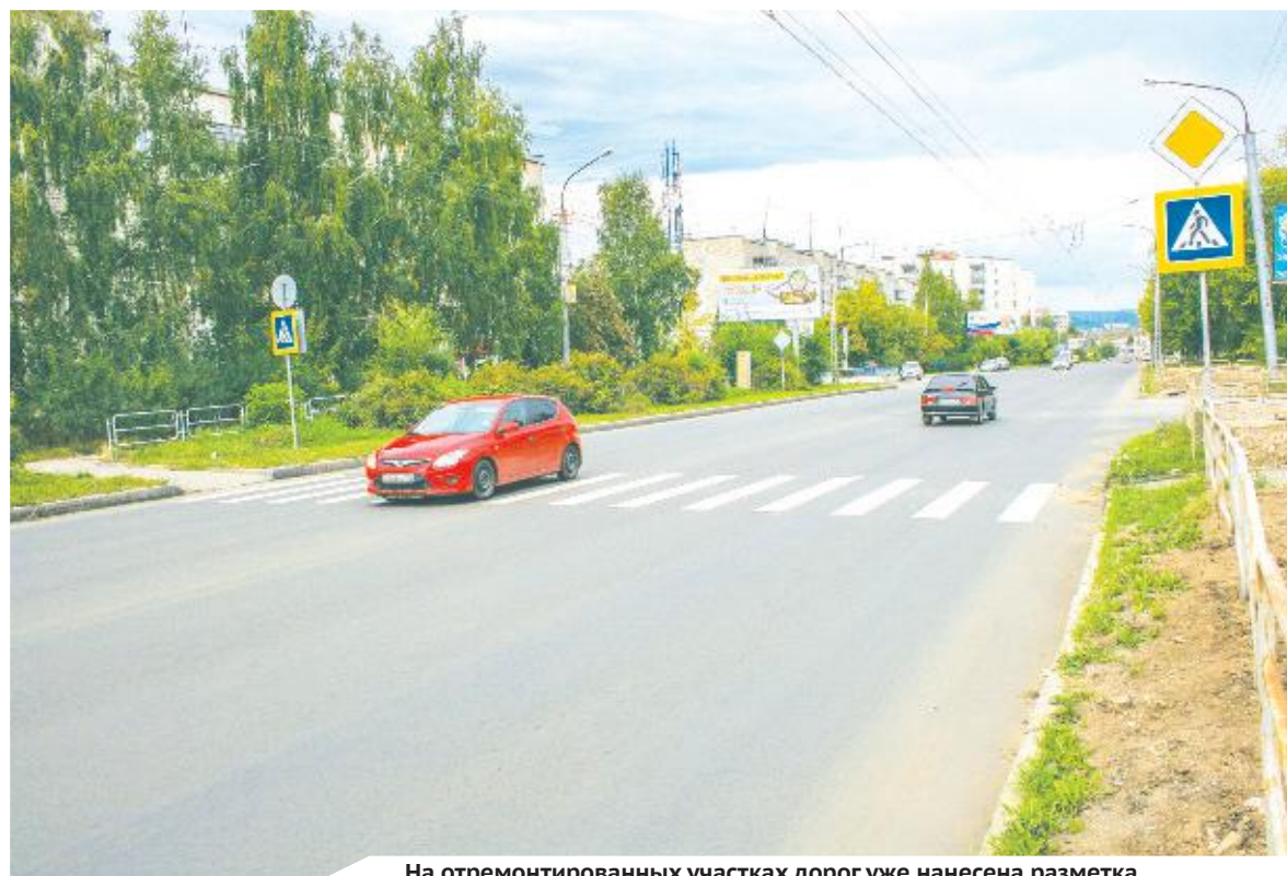
На отремонтированных участках дорог уже нанесена разметка.
