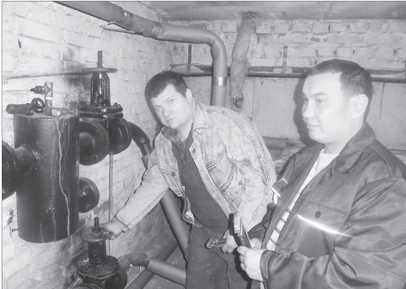
Специалисты УК «Рассвет-Энерго» Альберт Абдрафиков (слева) и Иван Савинов проводят ревизию задвижек.
