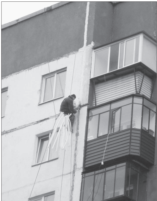
Идет герметизация швов дома № 3 на ул. Степана Разина.
