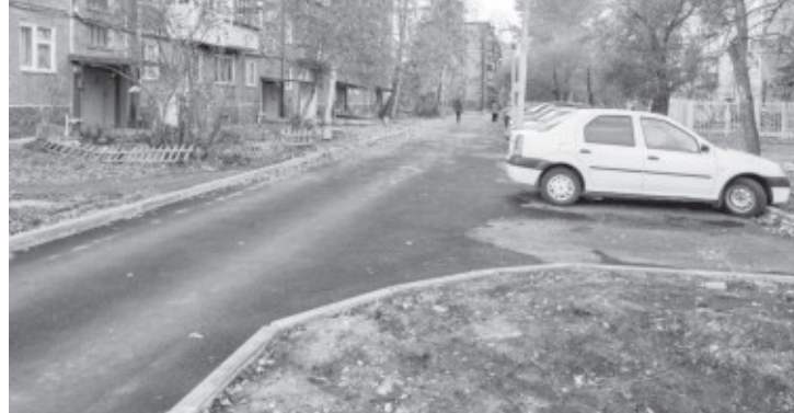
Этот же двор после ремонта
